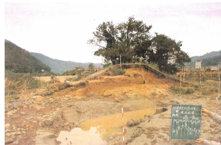
◆破堤状況 (出石川10k付近)
