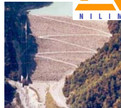
ロックフィルダム(高瀬ダム)
