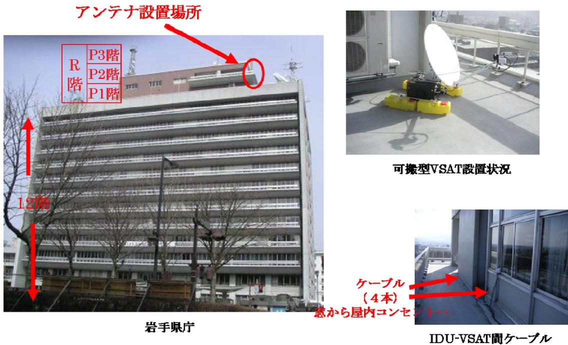
図 2.2-4 岩手県庁への屋外装置 (ODU) 設置状況
