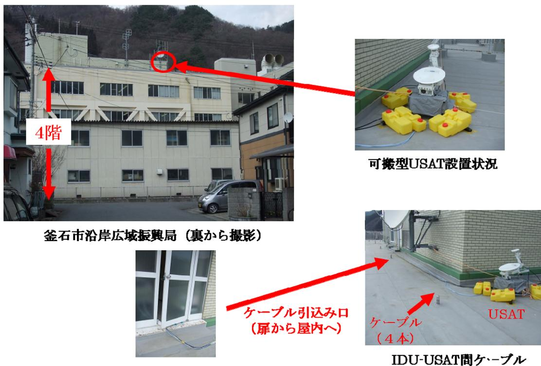
図 2.2-6 釜石市沿岸広域振興局への屋外装置（ODU）設置状況
