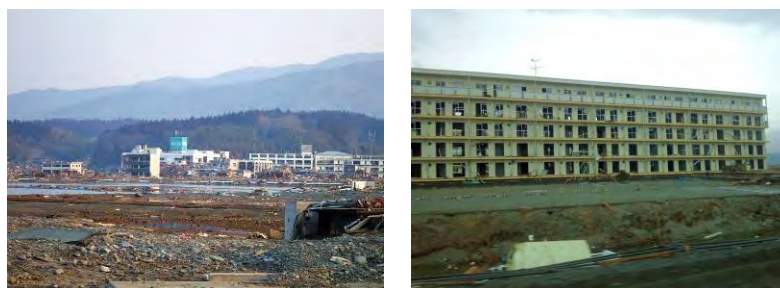
図 2.2-21 津波による被害状況（陸前高田市付近）
