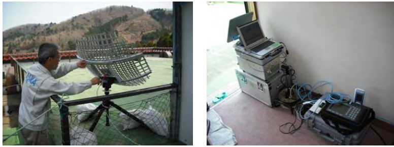
図 2.2-26 通信機器等の設置状況（左：アンテナ、右：通信端末）
