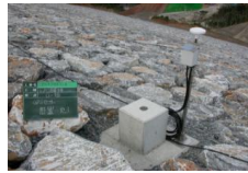
フィルダム堤体
