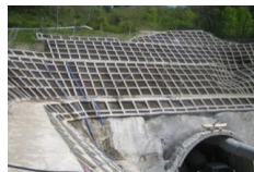
トンネル地表面
