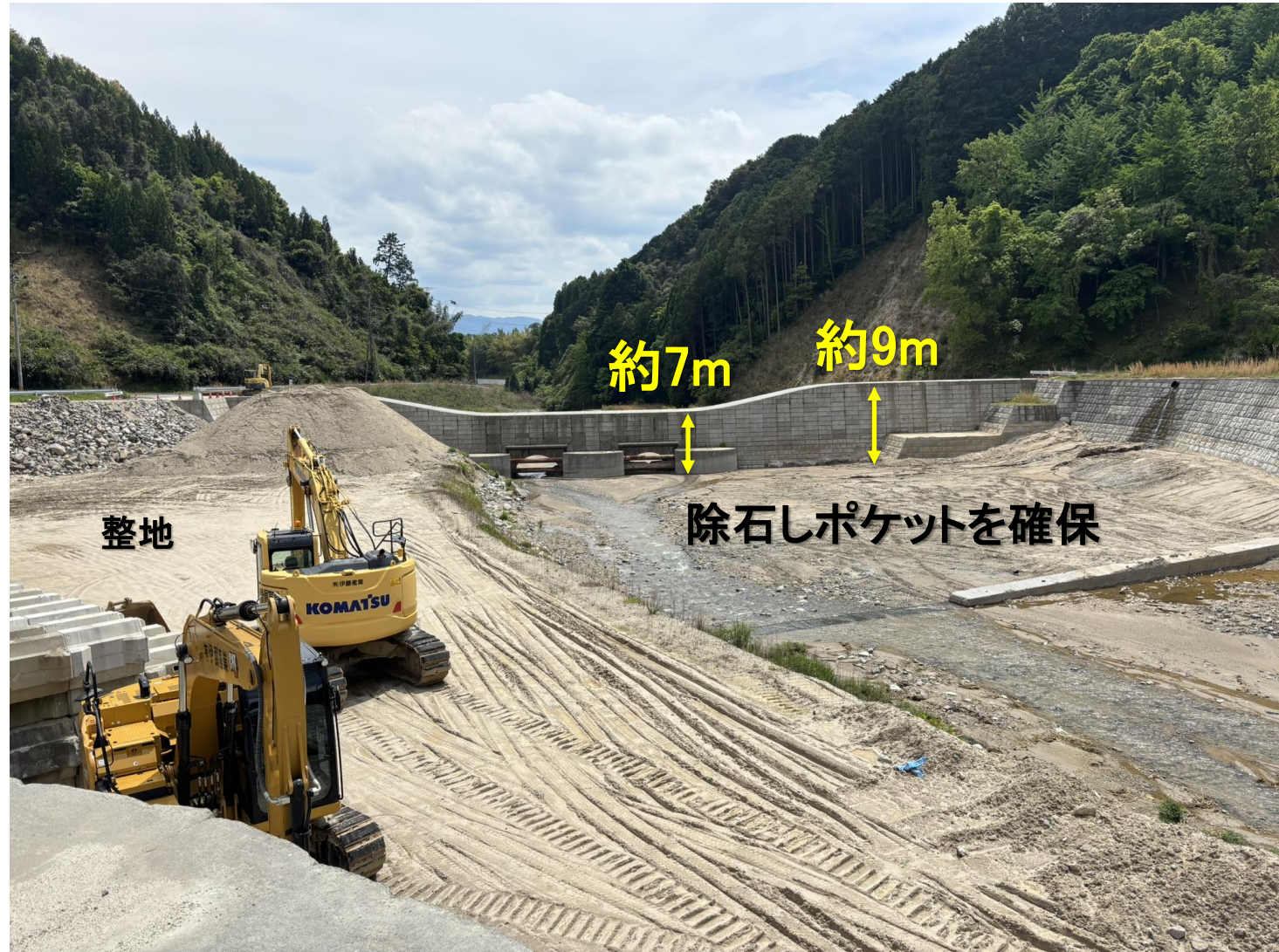
公道を利用し上流側から撮影（2026年5月7日）
