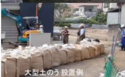
大型土のう袋 積み込み状況
