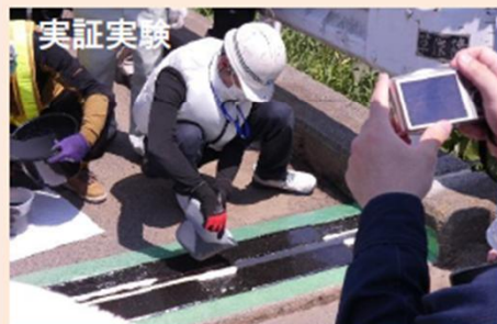
橋梁における補修工法の試験施工
