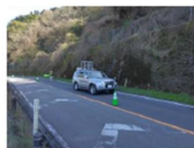
MMS※1を活用した 斜面・のり面点検
