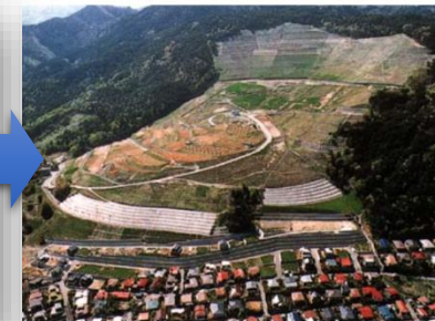
地すべり整備後 （ハード対策：地すべり対策工事）
