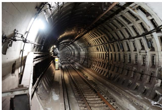
シールド工事が行われたトンネル
