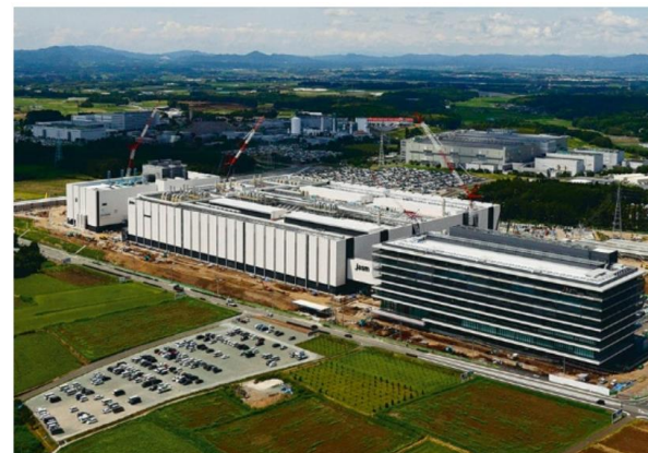
熊本県菊陽町に建設中のTSMC（運営子会社JASM）の半導体工場。年間310万tの地下水をくみ上げる
