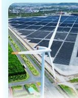
発電所 敷地内・敷地周辺地盤調査
